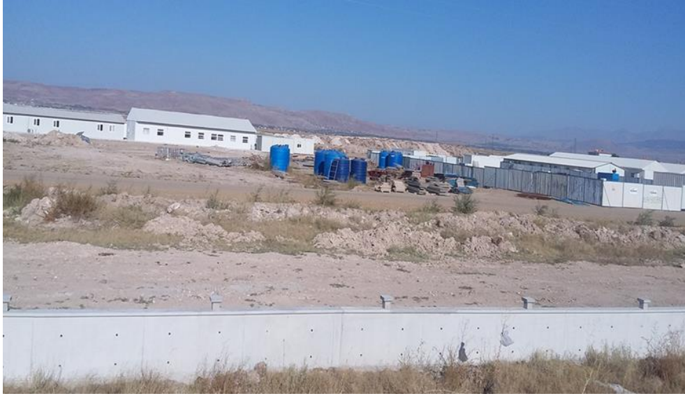
Şekil 4. Aksaray ili yeni sanayi inşaat alanı
